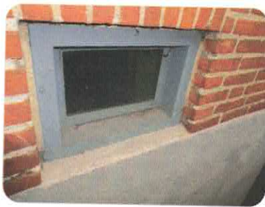
Her ses eksempel på murværk og sokkel.
