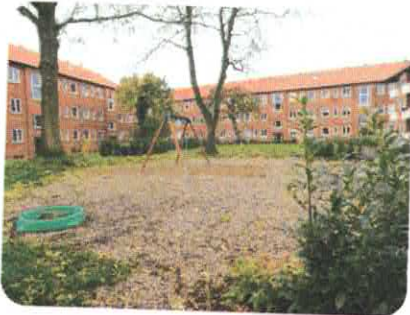
Ny tagbeklædning og nye tagrender og tagedløb.
